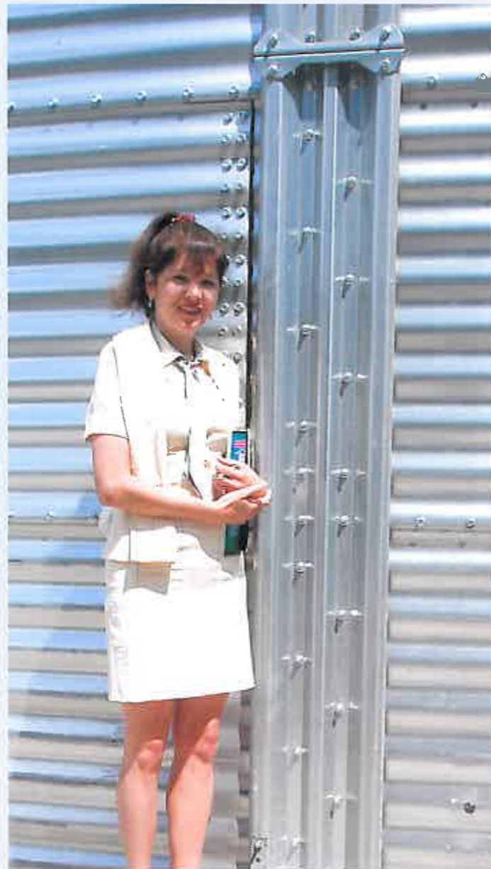
W-образное ребро жесткости и волнистая конструкция боковых стен зернохранилища
